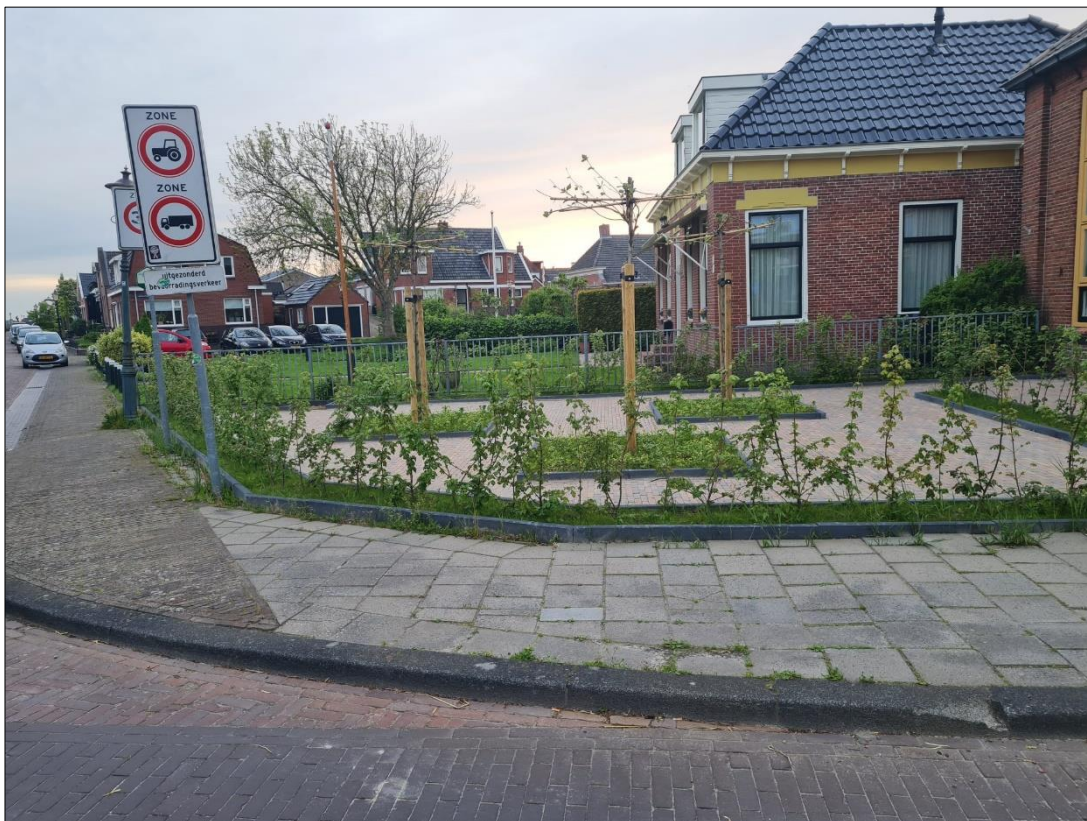
Op de voorgrond het voormalige schoolplein, Hoek Wilhelminastraat/Churchillweg, 2024
